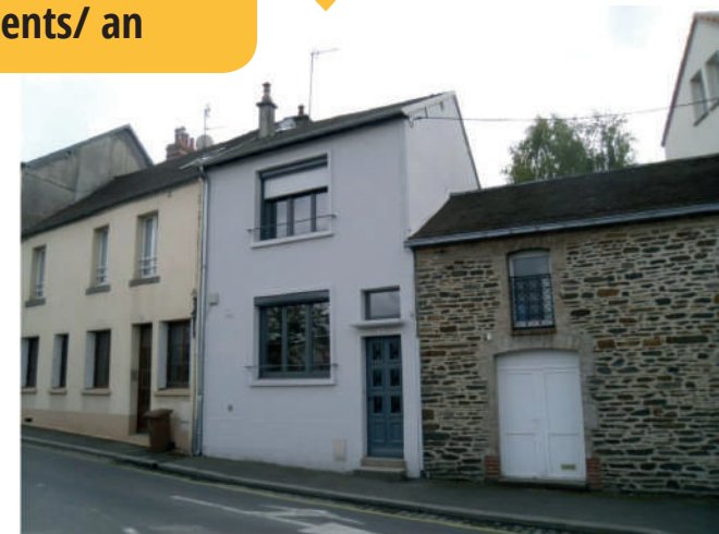
Après travaux ; OPAH
