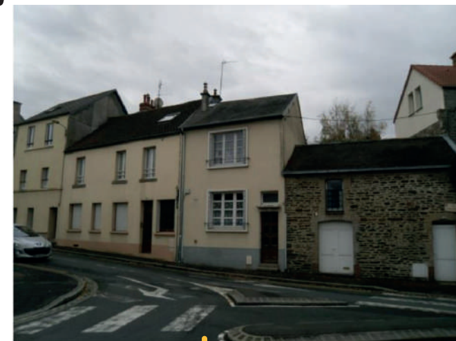
Avant travaux ; OPAH
